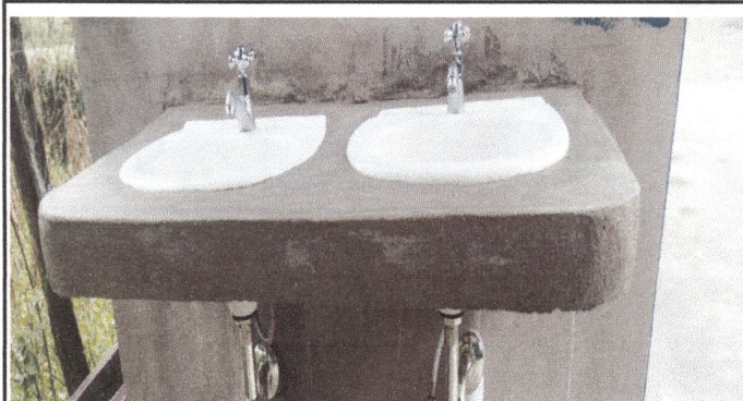
Foto 8: Vista de trabajos de instalación de tubería de lavamanos
