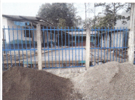
Foto 4: Barandas en 75% de instalación
