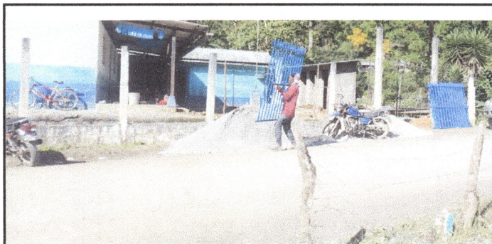
Foto 3: Barandas del muro perimetral en proceso de instalación
