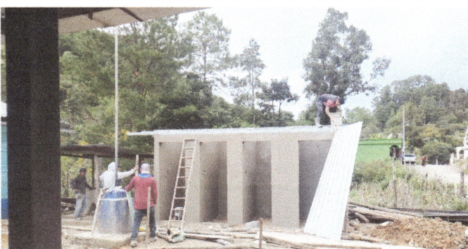
Foto 9: Colocación de estructura de techo y cubierta de lámina en sanitarios
