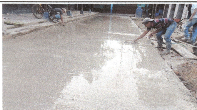
Foto 2: losa de patio en proceso de rehabilitación
