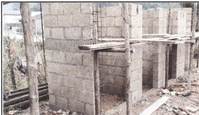
Foto1: Trabajos en proceso de sustitución de baños
