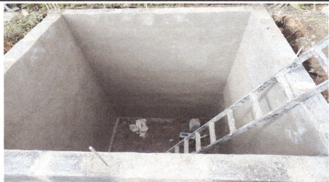
Foto 7: Implementación de fosa séptica de 2X2X3 metros
